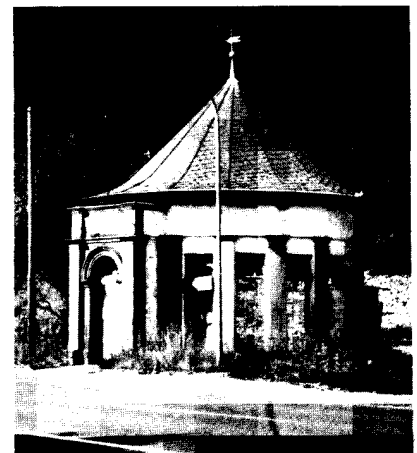
Abb. 3 Das vermutlich um 1860 erbaute und in einem beklagenswerten Zustand zum Teil noch erhaltene Quellhaus der Birresborner Mineralquelle (Aufnahme: Oktober 1982)
